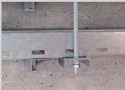
Fixação de varão roscado vertical com suporte de suspensão.
