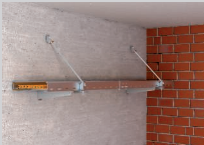
Instalação na parede com apoio inclinado de varão roscado.
