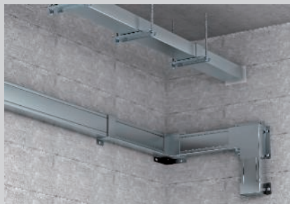
Instalação direta na parede e no teto.
