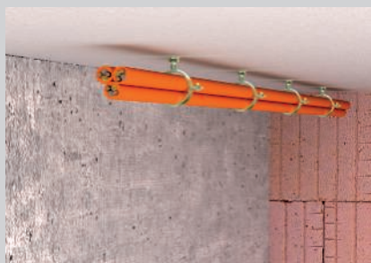
Colocação de Conjunto de cabos sob o teto.
