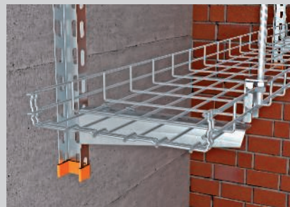
Fixação dos caminhos de cabos em varão eletrosoldado na consola de encaixe rápida.
