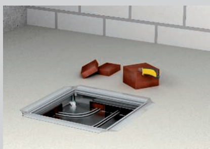
Cortar tiras finas para os compartimentos da calha.
