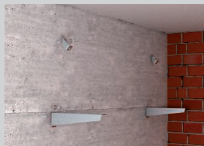
Instalação da consola e dos componentes de ligação inclinados na parede.
