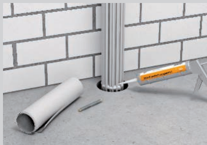
Preparação da selagem de cabos.
