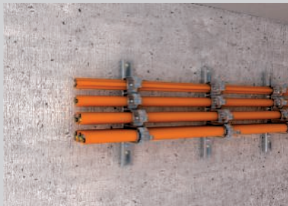
Instalação horizontal de cabos com abraçadeiras BBS na parede.
