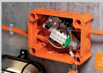
Entrada de cabo com buçins cônicos.
