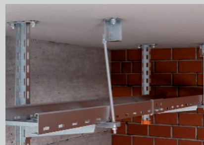
Suspensão do varão roscado no suporte de teto antifogo.
