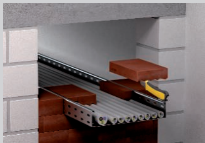
Montagem de blocos seccionados.
