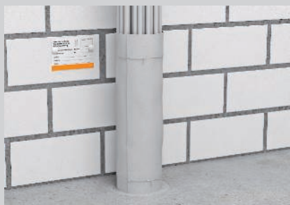
Fechar a abertura restante da antepara com argamassa e montar a etiqueta de identificação.
