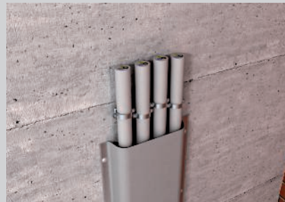
Fixação da envoltura numa instalação com abraçadeiras metálicas individuais.
