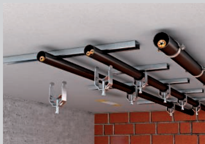
Montagem no teto com abraçadeiras de aperto e abraçadeiras BBS.
