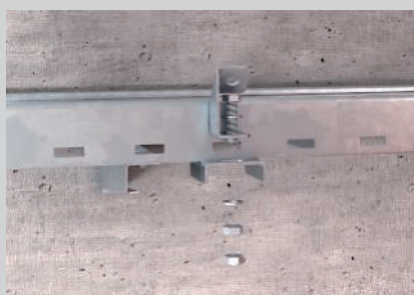
Montagem do suporte de ligação na diagonal com parafusos e porcas sextavadas.
