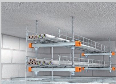
Instalação no teto a dois níveis, por cima do teto suspenso de proteção contra incêndios.
