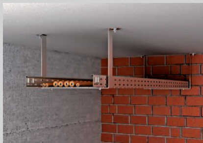
Instalação de um nível no teto com consola de teto.
